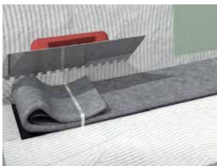
11. Aplique o cimento cola de classe C2 nas juntas e pendentes na lâmina DRY50 vulcanizada da LINEAR/SUMI LEVEL .
