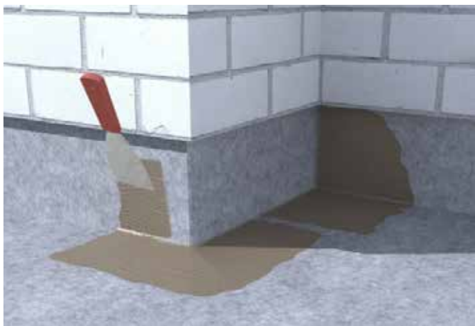
1. Uma vez instalada a lâmina ECODRY50/80/120 , aplicar o adesivo SEALPLUS na zona dos cantos.
