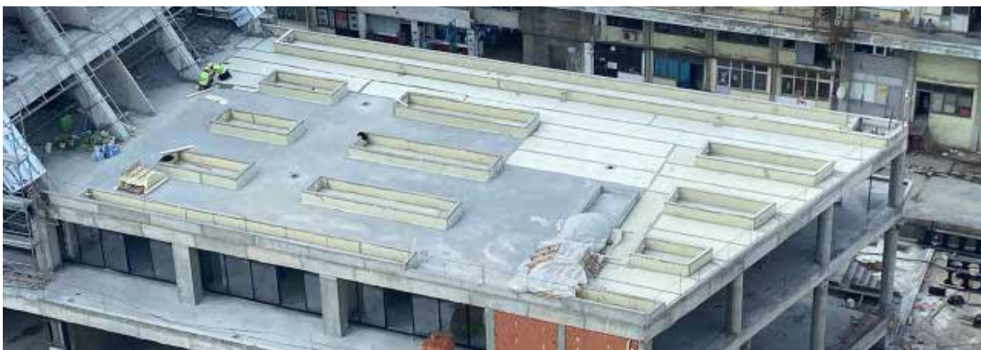
Impermeabilização de 20.000 m 2 de DRY120 em todos os seus terraços transitáveis exteriores. ISTMALL ESTAMBUL. Edifício para oficinas, universidad e centro comercial. Estambul. Turquia.
