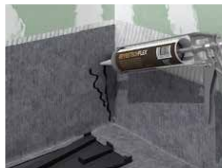
13. Para formar os cantos sobreponha a lâmina. Aplique REVESTTECHFLEX para colar a dobra e selar.
