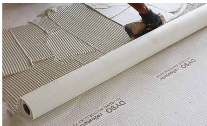
2. Aplicar o cimento cola classe C2 S1/S2 com uma talocha dentada de 4 a 6 mm. Aplicar o adesivo em pequenas porções para evitar que seque. A película DYSO não deve, em caso algum, ser instalada sobre um cimento cola semicurado.
