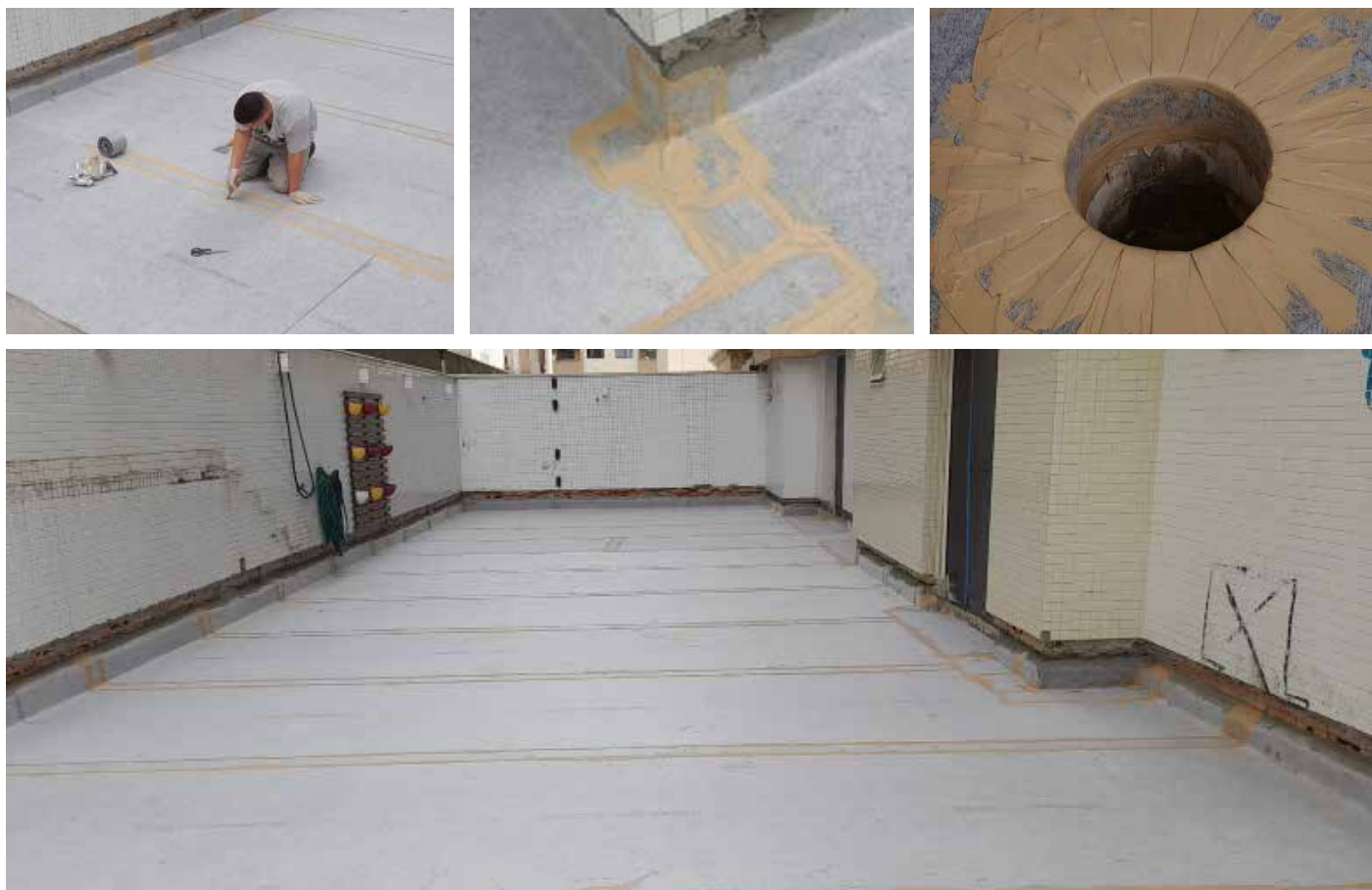
Impermeabilização de 700 m 2 com ECODRY120 en todas sus terrazas transitáveis exteriores. Condominio en Itapema. Brasil.
