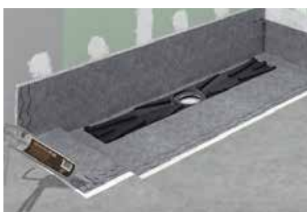
14. Aplicar um cordão de adesivo REVESTTECHFLEX antes de sobrepor a lâmina, do resto, do duche.
