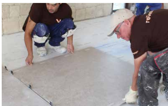
6. Antes de instalar o mosaico, aguarde pelo menos 24 horas para que o cimento cola da lâmina seque. Utilize o adesivo recomendado pelo fabricante da cerâmica para a sua adesão à lamina.
