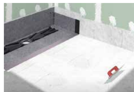
16. Cubra o pavimento do chuveiro com cimento cola C2 e cole a folha DRY50 incluída no kit.
