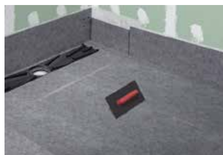
15. Verifique se a lâmina está bem estendida e remova o ar que possa ter sido gerado com a ajuda da espátula.
