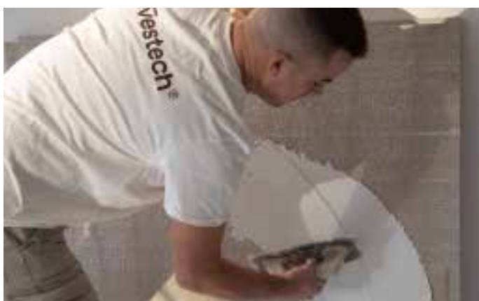
5. Para as cerâmicas de grande formato, é igualmente necessário aplicar um adesivo nas peças: DUPLA COLAGEM .
