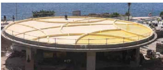
Impermeabilização con DRY80 de la cubierta del bar piscina del resort de 5 estrellas de la CADENA H10_Costa Adeje (Tenerife).
