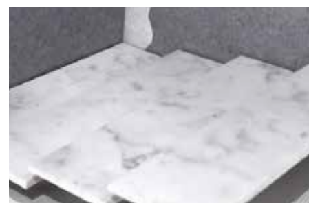
19. Prossiga para a pavimentação da cerâmica, partindo da LINEAR/SUMI LEVEL e tendo como guia a peça colocada sobre a base.
