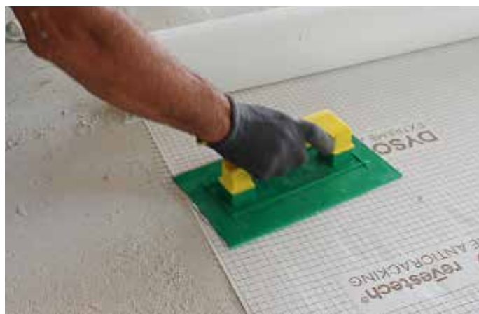
4. Pressionar firmemente a lâmina DYSO sobre o suporte com a ajuda da espátula de plástico, tendo o cuidado de eliminar as rugas que possam ter sido geradas.
