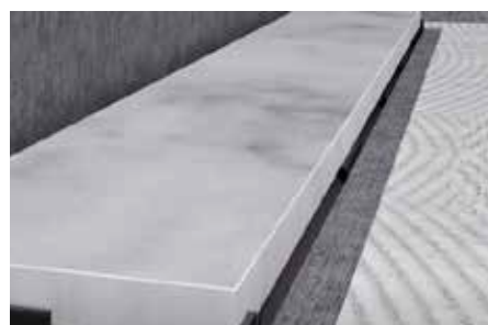
18. Coloque a peça de cerâmica sobre a LINEAR/SUMI LEVEL .
