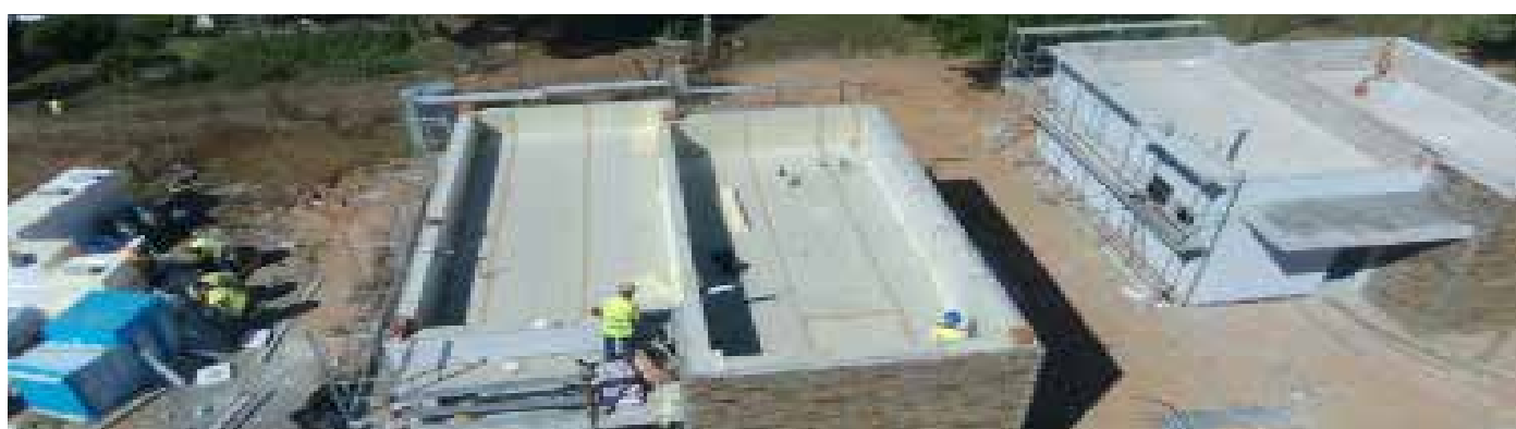
Impermeabilização das coberturas com DRY80 . LAR DE 3ª IDADE EM LENSTISCAIS. Castelo Branco. Portugal
