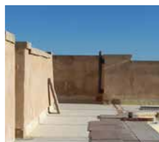
Impermeabilização con DRY80 de la cubierta del bar piscina del resort de 5 estrellas de la CADENA H10_Costa Adeje (Tenerife).
