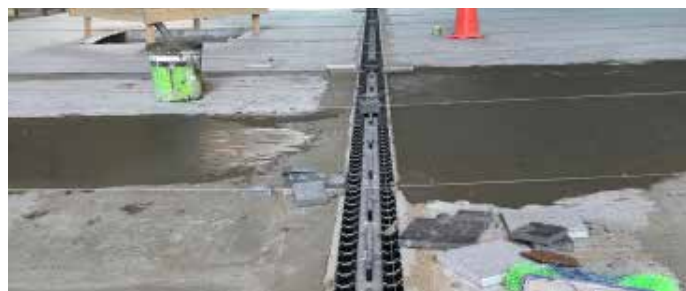
Impermeabilização de 18.000 m 2 con DRY120 e canalización con WALK LEVEL . PROYECTO RESIDENCIAL E COMERCIAL URBANA APOQUINDO. Santiago de Chile.
